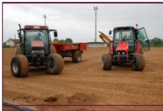
Réfection du terrain de football
